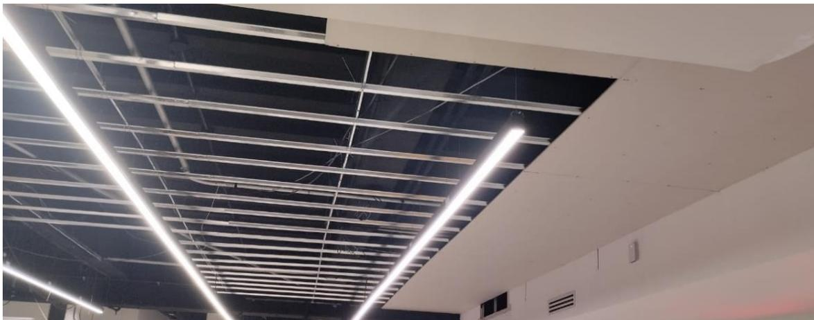
Colocación de planchas, enmasillado a 3 manos, lijado y pintura para acabado final.
